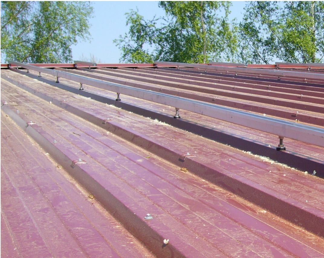
Abbildung 88: C-Schiene als untere Ebene des Kreuzschienenverband
