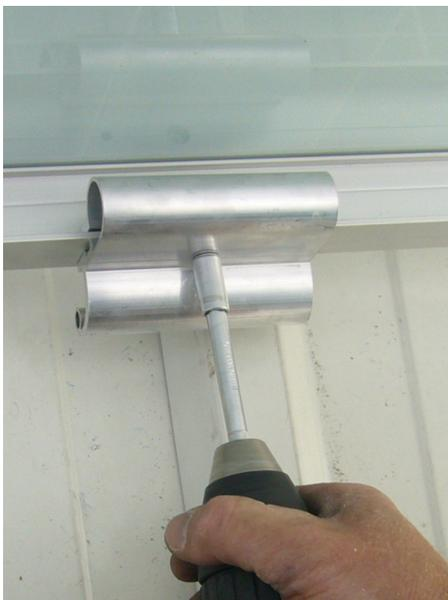
Abbildung 148: Montage „Modulbefestiger-Set“ vorne
