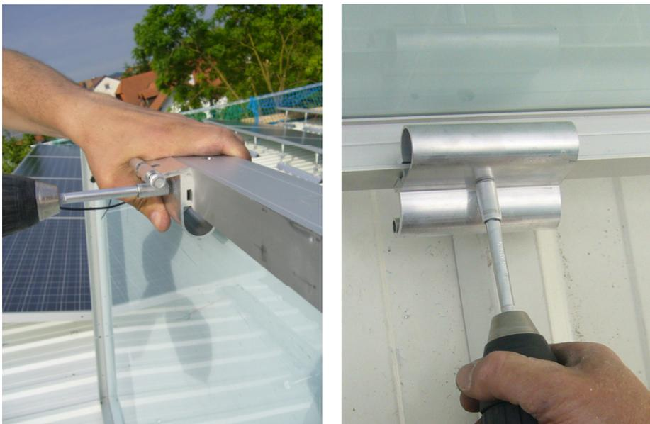
Abbildung 93: Montage „Modulbefestiger-Set“ hinten (links) und vorne (rechts)
