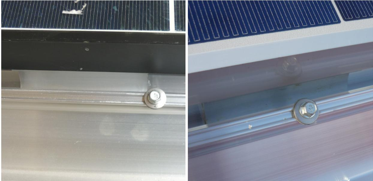
Abbildung 151: Modulsicherung am „Modulbefestiger-Set vorne“ neben oder durch den Modulbefestiger
