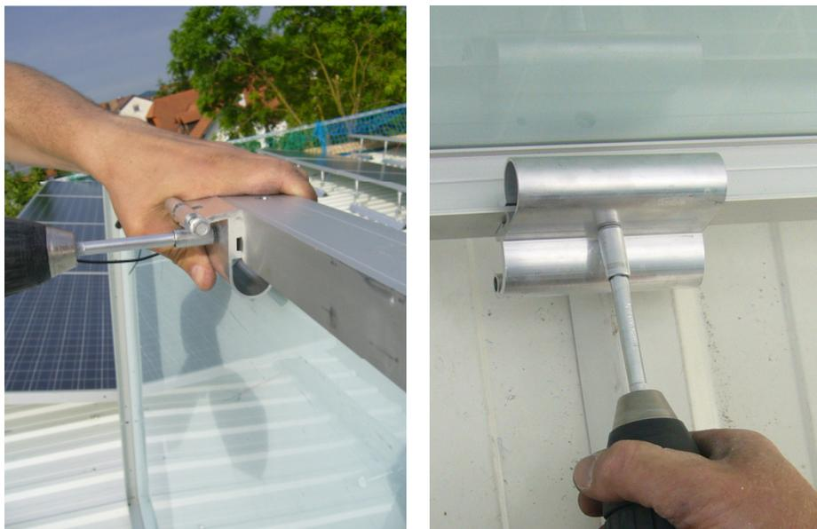
Abbildung 71: Montage „Modulbefestiger-Set“ hinten (links) und vorne (rechts)
