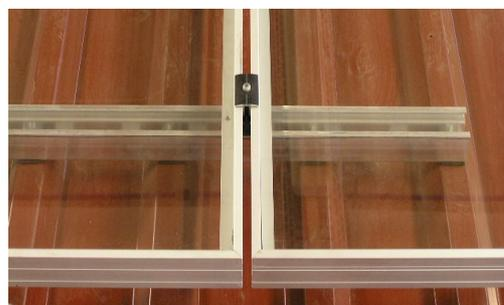
Abbildung 40: Detail zur Befestigung der C-Schienen am Trapezblechdach – Verstärkte Befestigung
