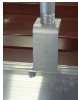
Abbildung 108: Modulsicherung am „Modulbefestiger-Set vorne“ (links) und am „Modulstützen-Set“ (rechts)
