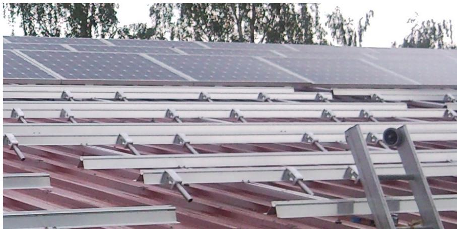
Abbildung 105: Eingelegte Modulstützen-Set (Beispielhaft Süddach mit Stockschraubenmontage)
