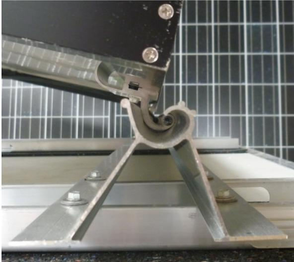
Abbildung 141: Steg (links) und Eindrehschnecke (rechts)
