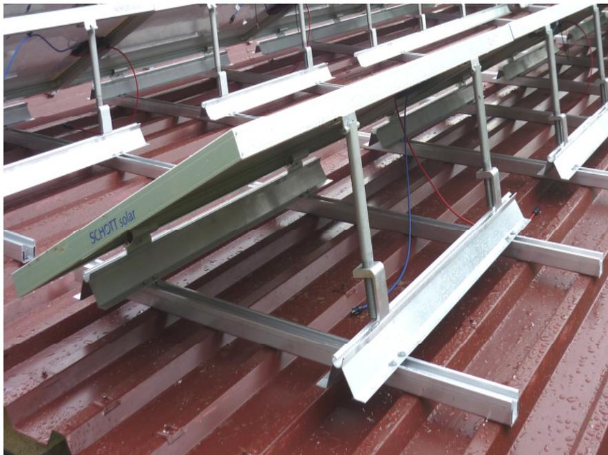
Abbildung 73: Höhenverstellbare Modulstützen
