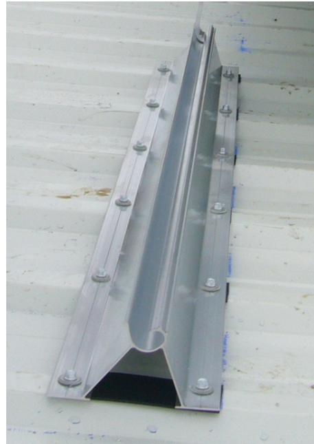
Abbildung 55: Basisprofil mit Abdichtung und beidseitiger Verschraubung. Steg (links) und Eindrehschnecke (rechts).
