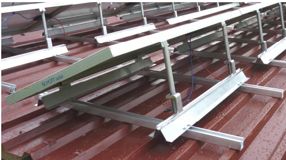
Abbildung 63: C-Schiene als untere Ebene des Kreuzschienenverband
