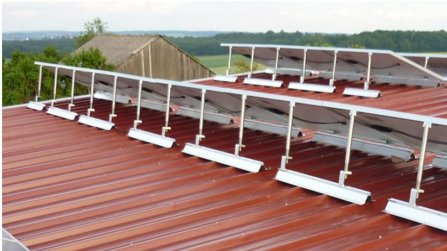
Abbildung 58: Höhenverstellbare Modulstützen
