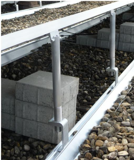
Abbildung 135: Höhenverstellbare Modulstützen
