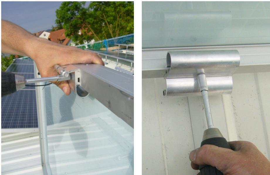
Abbildung 56: Montage „Modulbefestiger-Set“ hinten (links) und vorne (rechts)
