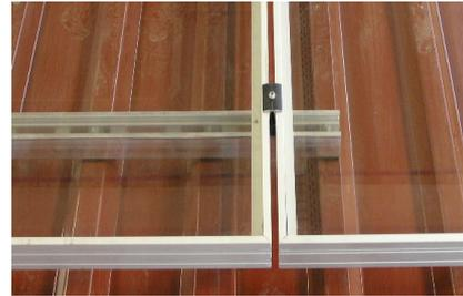
Abbildung 38: Detail zur Befestigung der C-Schienen am Trapezblechdach – Standardbefestigung
