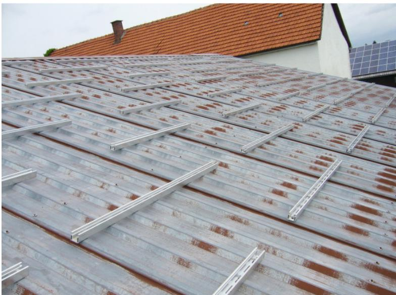
Abbildung 44: Alternative 2 – alternierende Schienenanordnung
