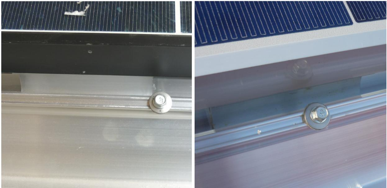
Abbildung 136: Modulsicherung am „Modulbefestiger-Set vorne“ neben oder durch den Modulbefestiger
