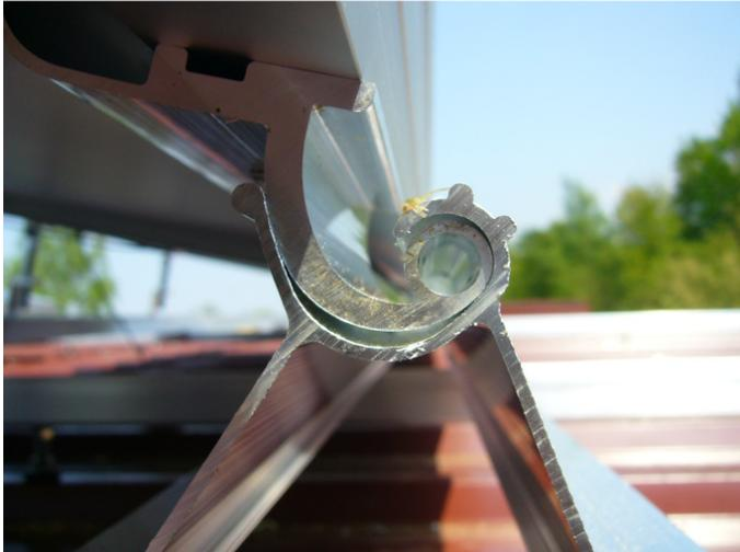
Abbildung 90: Steg (links) und Eindrehschnecke (rechts)
