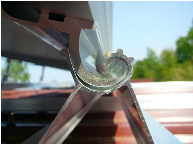
Abbildung 68: Steg (links) und Eindrehschnecke (rechts)
