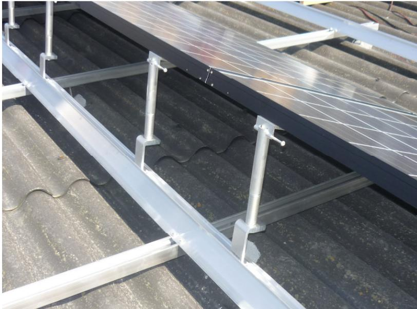
Abbildung 106: Höhenverstellbare Modulstützen
