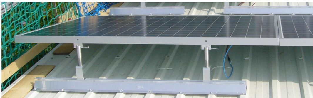
Abbildung 51: Basisprofilverlängerung am Ortgang
