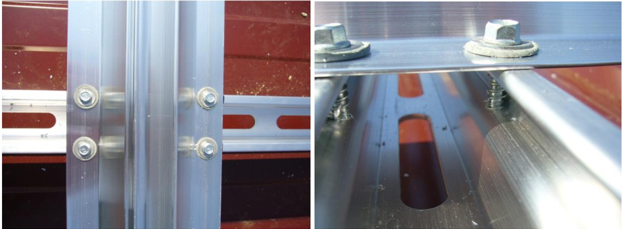
Abbildung 70: Basisprofilbefestigung auf den C-Schienen
