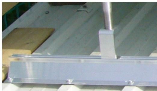
Abbildung 53: Detail zur Befestigung der Basisprofile am Trapezblech – Verstärkte Befestigung
