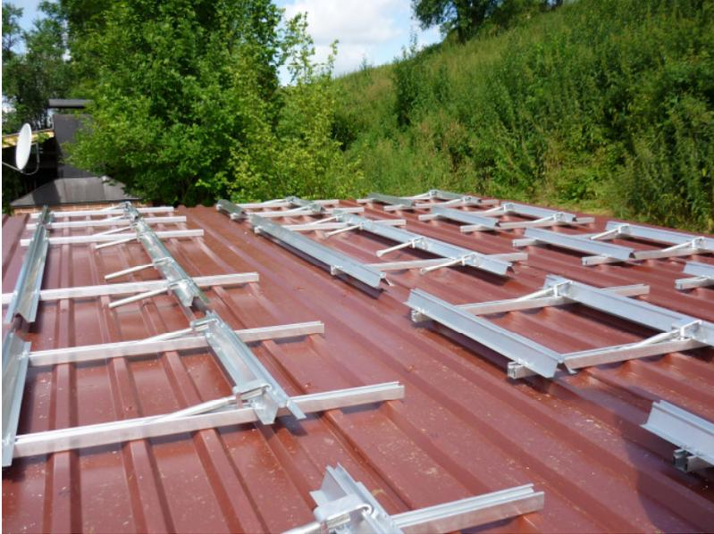
Abbildung 72: Eingelegte Modulstützen-Set
