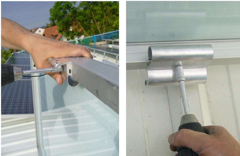
Abbildung 133: Montage „Modulbefestiger-Set“ hinten (links) und vorne (rechts)
