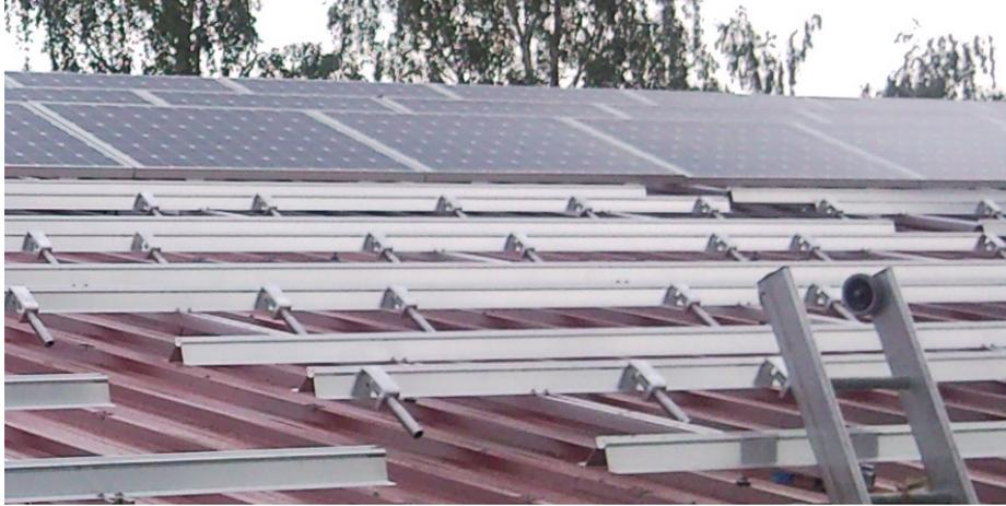
Abbildung 94: Eingelegte Modulstützen-Set
