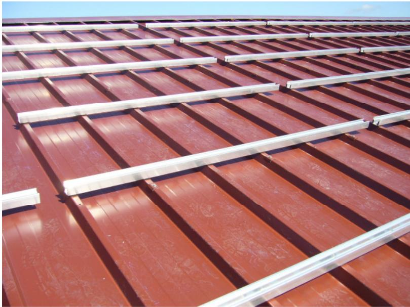
Abbildung 43: Alternative 1 - Verlängerung der Schienenstück
