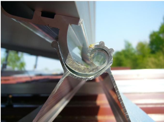
Abbildung 101: Steg (links) und Eindreh Schnecke (rechts)
