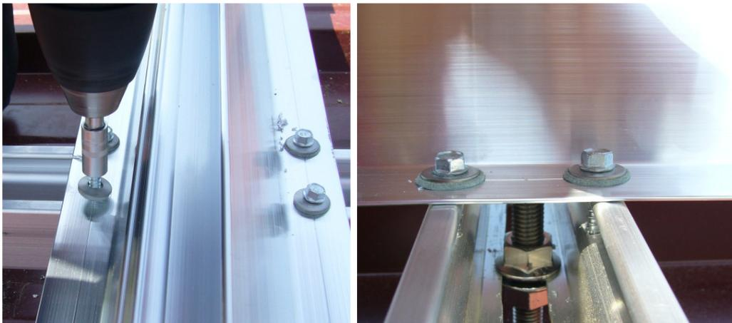
Abbildung 103: Basisprofilbefestigung auf den C-Schienen
