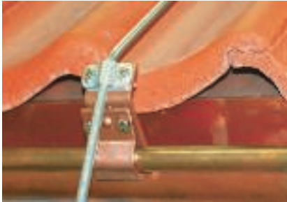
Helyes beépítés kettősfém-összekötővel (alu/réz)
